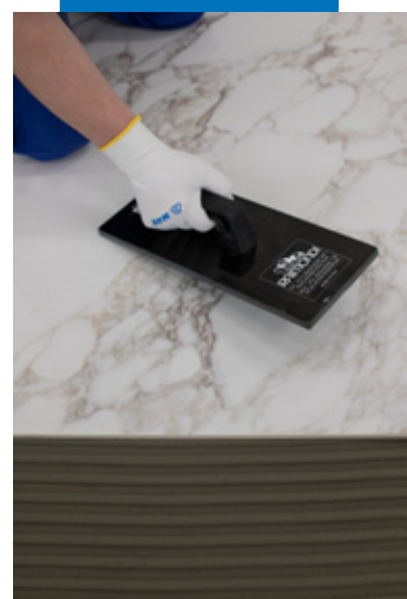
Укладка керамогранита размером 240 x 120 см
