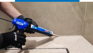
Нанесение герметика
